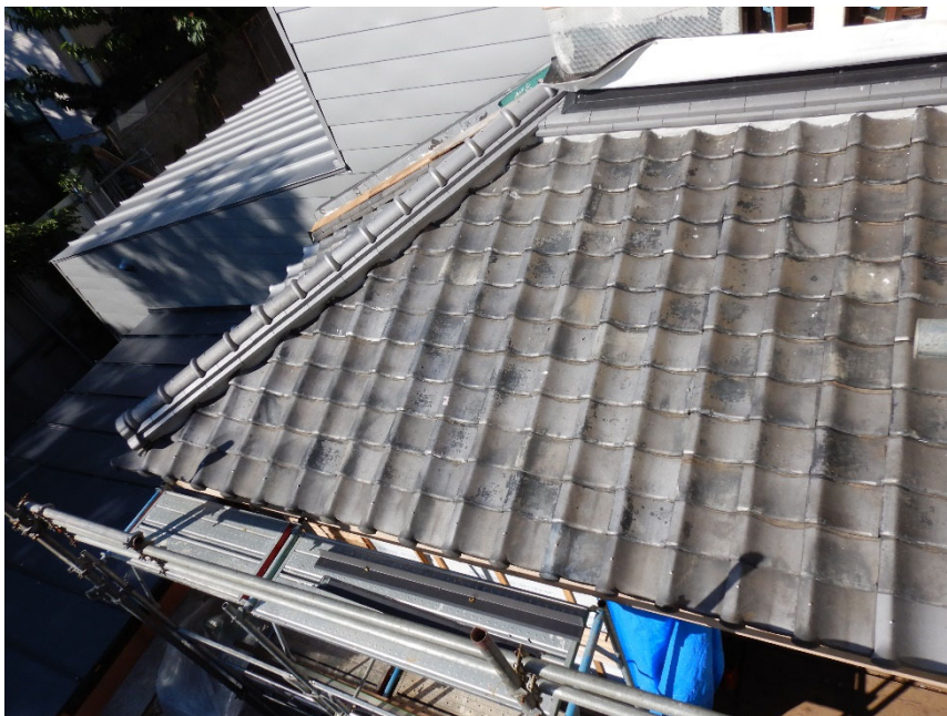
令和4年9月 既存部 玄関庇の既存瓦の 再利用
