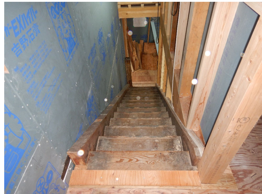
令和4年9月 既存部 階段2の架け替え (既存材の再利用)
