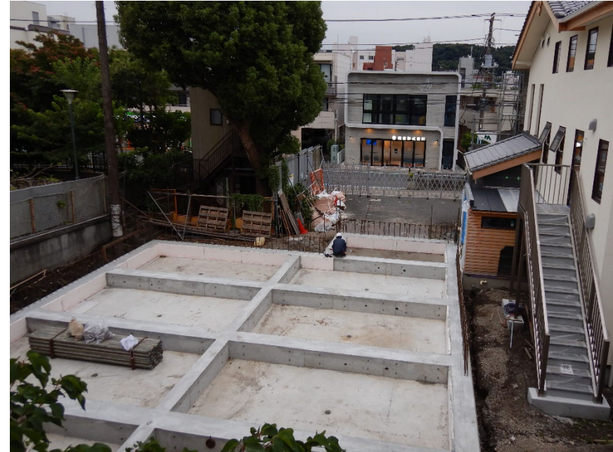
令和4年9月 RC増築部 基礎工事の完了
