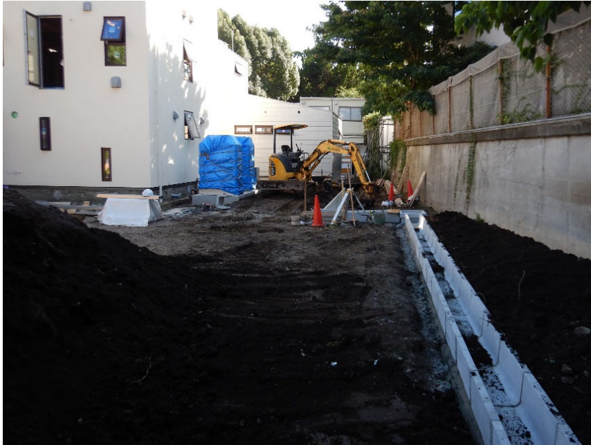
令和4年8月 RC増築部西側 側溝の設置・ 空調機器の設置
