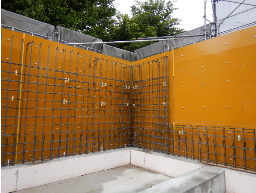
令和4年10月上旬 RC増築部 壁の配筋 着手
