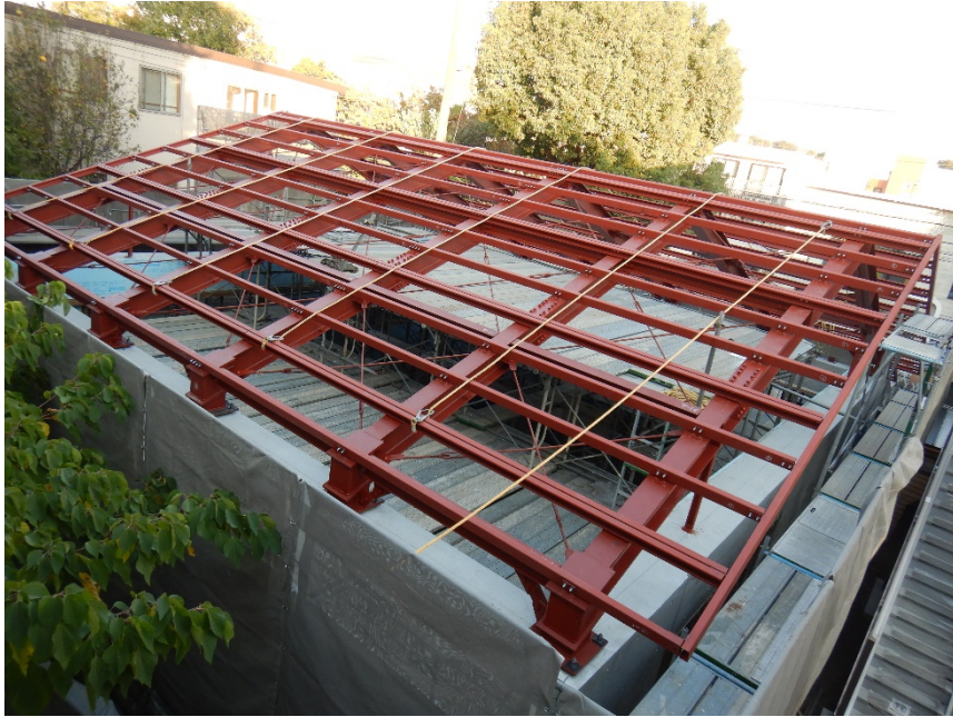
令和4年11月上旬 RC増築部 鉄骨小屋組み
