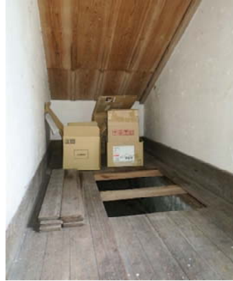
① 1階の床下点検口(階段下)
