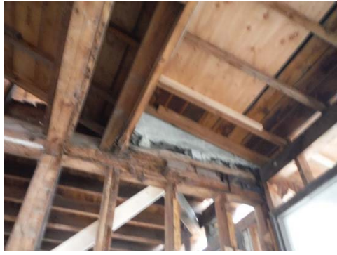
Ⅷ 1階梁 ⑤通り・ロ-ハ間（屋内）
