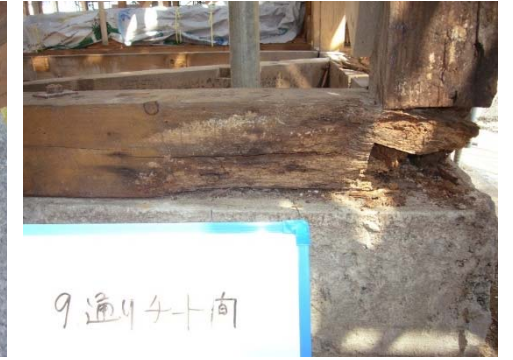
内外装撤去時(外側から撮影) VIII 土台 ⑨通り・チト間(外側)
