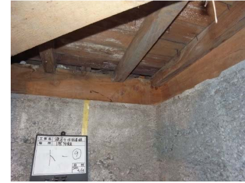
耐震診断時(内側から調査) viii 土台 ト通り・⑨(内側)
