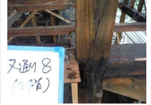
II 2階柱 又通り・⑥（外側）
