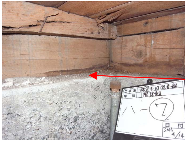
土台 ⑦通り・ハ付近
