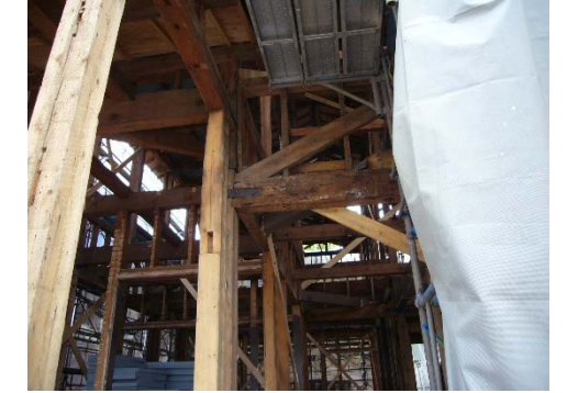
IV 3階柱 又通り・⑥（外側）
