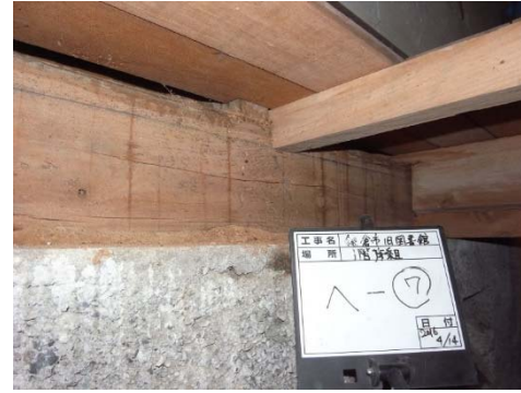
耐震診断時(内側から調査) ix 土台 ⑦通り・へ付近(内側)
