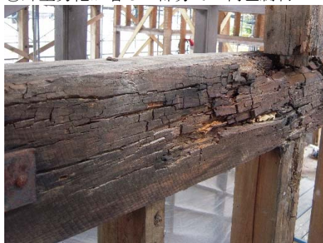
②トイレ周囲の土台の腐朽・蟻害
