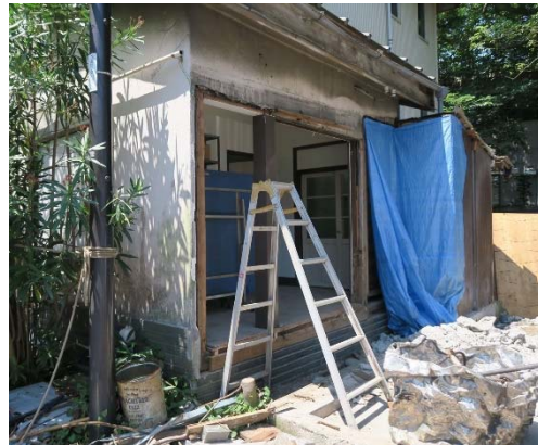
⑤ 増築接続部 (ル通り)
