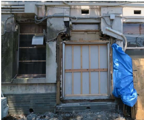
④ 増築接続部 (1通り・ホーへ)
