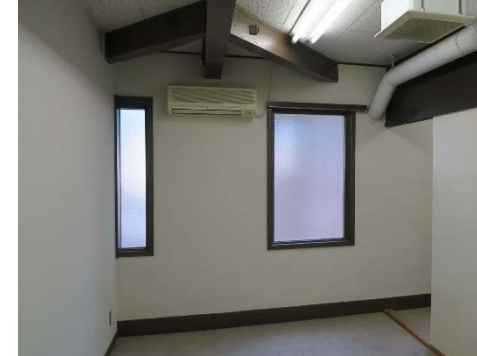
iii 2階柱 又通り・④（内側）
