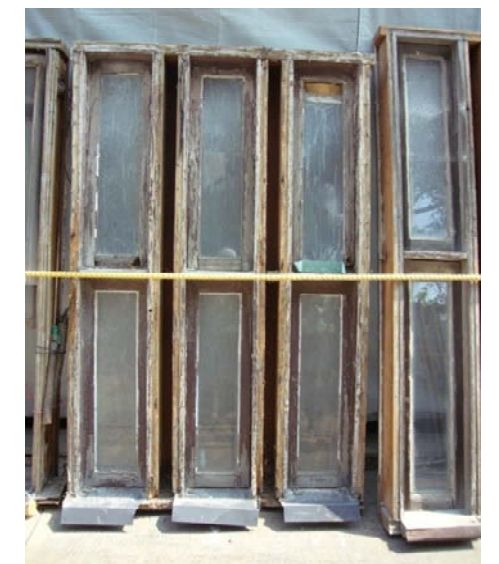
1階三連窓 取り外した状態 (内側枠)
