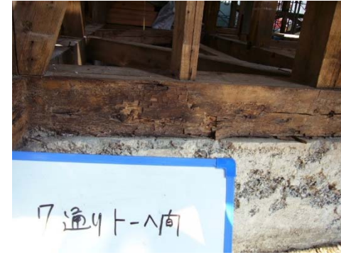
内外装撤去時(外側から撮影) IX 土台 ⑦通り・トへ間(外側)
