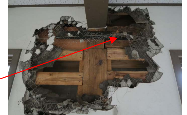
2階桁 又通り・⑥付近
