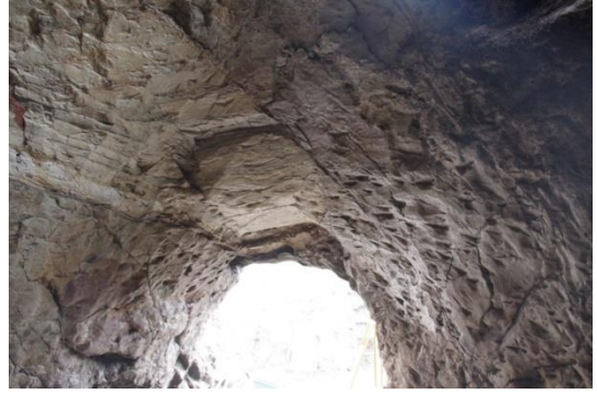
入口部分天井
