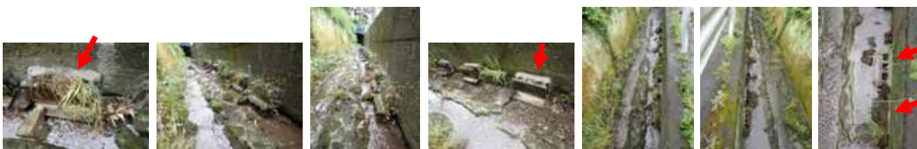
ブロック上部に植栽 復旧後
