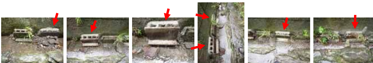
復旧作業後 ブロック上部に植栽
