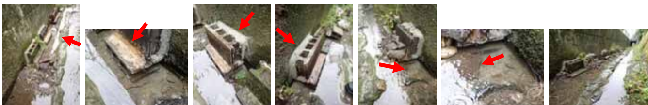
排水後 ブロックが外れた箇所 ブロックの復元作業後 ヨシノボリ が隠れた
