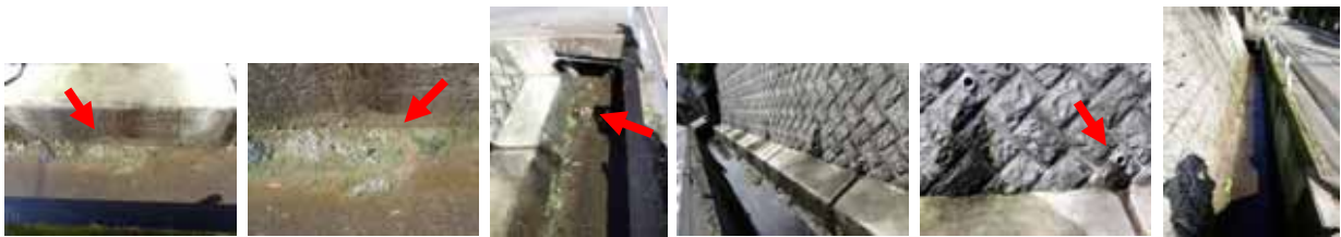
落下したダダンゴケの群落 流出したモルタル 上流側から 最上流の水抜き管
