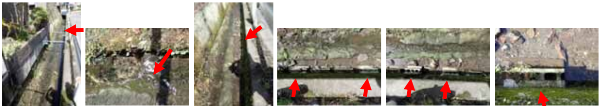
エコアップ箇所 甑穴 エコアップ箇所 先月、復旧作業を実施した修復箇所
