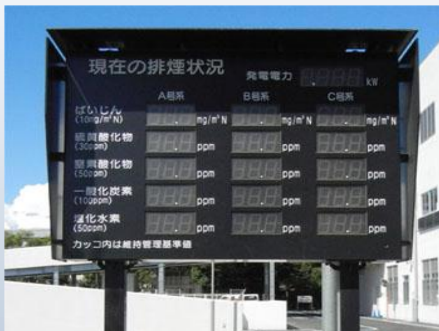
公害監視盤(平塚市)
