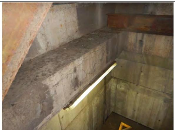
写真30 煙突内壁梁コンクリート
