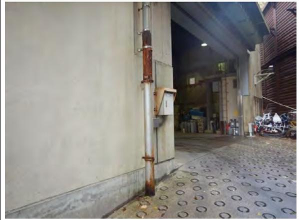
写真8 排水管腐食【要補修】
