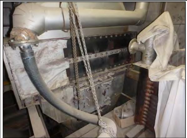
写真⑩ 2号温水発生用熱交換器
