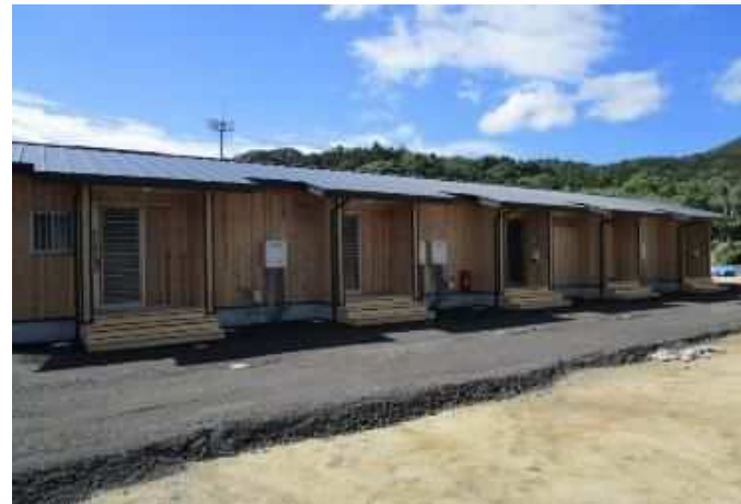
仮設住宅建設(3箇所、104戸)
