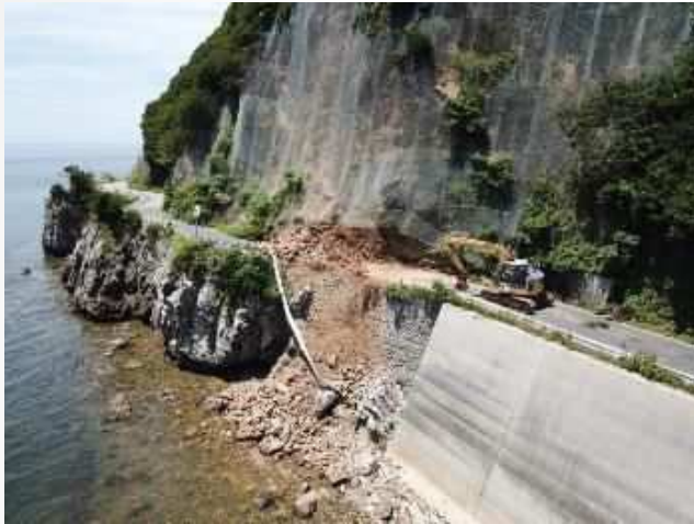
明浜町岩井 国道378号
