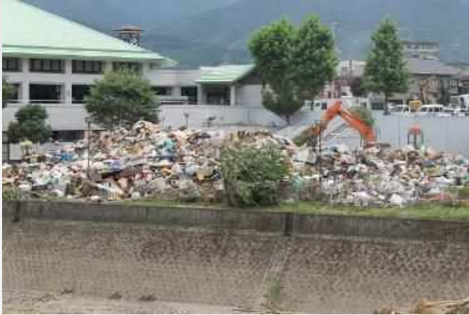
可燃ゴミ集積(乙亥会館付近)
