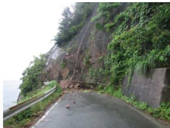
平成28年6月28日大雨による 国道378号土砂災害
