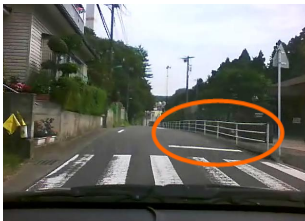
図 3.10-2 ガードパイプの例
