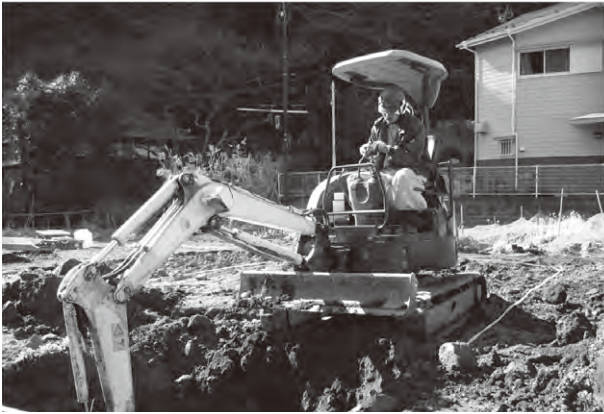
2. I区表土掘削（南東から）
