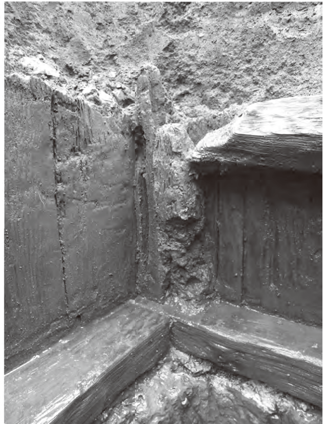
6. 井戸枠 北西隅の支柱（南から）
