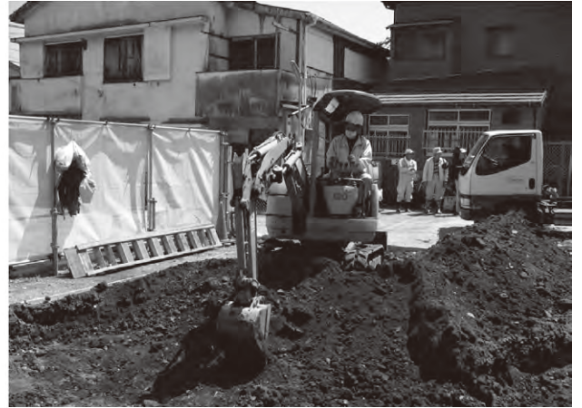
4. I・II区 表土掘削状況（西から）
