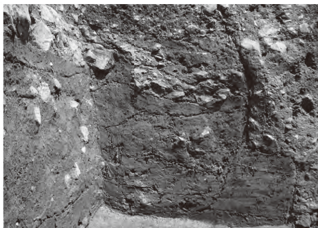
4. I区3面遺構214b断面(北西から)
