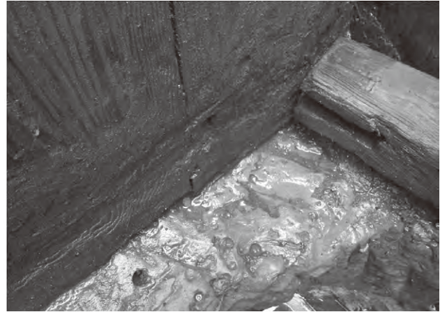
2. 井戸枠 北西隅の波食台岩盤と土台材 (南から)
