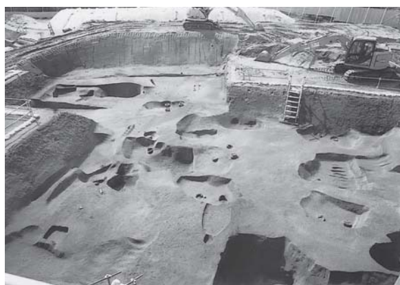
4. II区攪乱状況（部分・北から）
