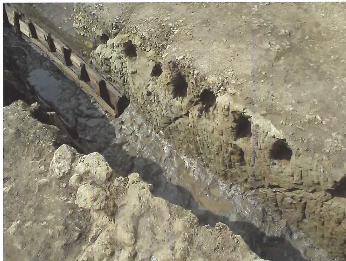
写真3 木製護岸と岩盤くり抜き部分(梁を渡すための穴がうたれている)
