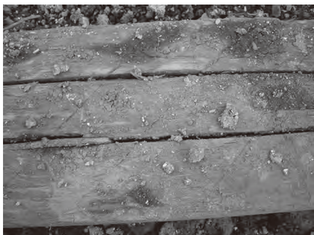
5面溝3部材裏面の三条の痕
