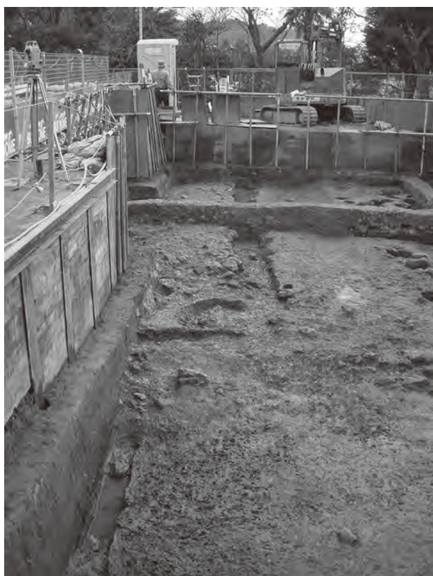
3面溝 2 と南方向遠景 (北から)
