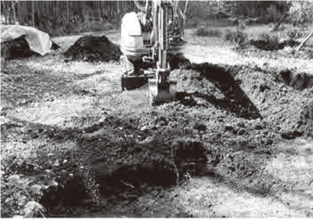
△1. 重機による表土掘削風景
