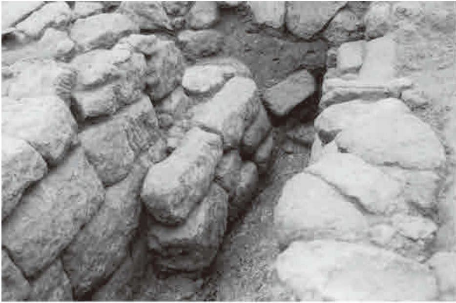
◀遺構 8a・8b 石積み状況
