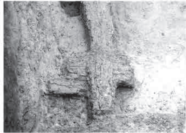
▲第4面遺構131根太出土状況(南から)
