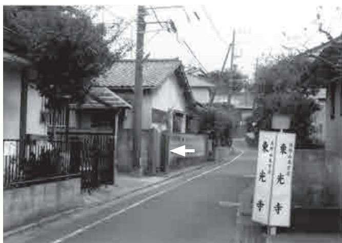
1-1 調査地点近景 (北から)
